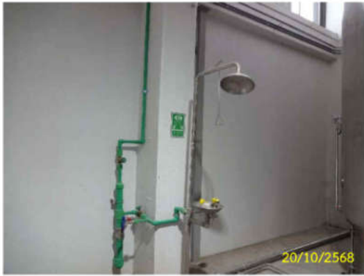
รูปที่ 30 จุดชำระล้างร่างกายและล้างตาฉุกเฉิน
