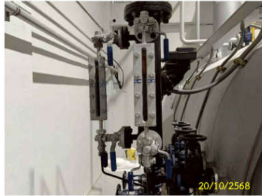
รูปที่ 2 การติดตั้งอุปกรณ์ตรวจวัดควบคุมการทำงานของหม้อไอน้ำ
