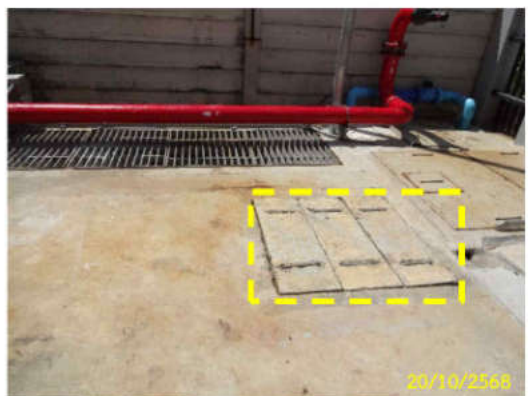
รูปที่ 11 บ่อพักน้ำทิ้ง ขนาด 140 ลบ.ม.
