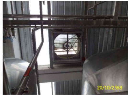
รูปที่ 31 ระบบระบายอากาศ/พัดลมเพื่อช่วยลดความร้อน
