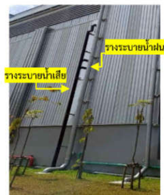
รูปที่ 14 รางระบายน้ำเสียที่แยกออกจากรางระบายน้ำฝน
